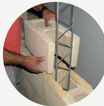
1. Cortando los bloques en forma de "A"
